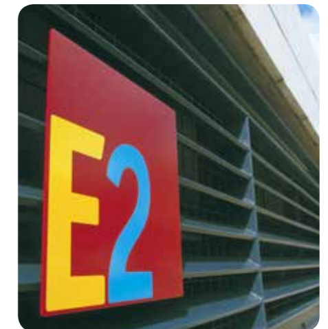
Identification sur le site
